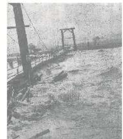
昭和 38 年の集中豪雨による水害（月見橋）
